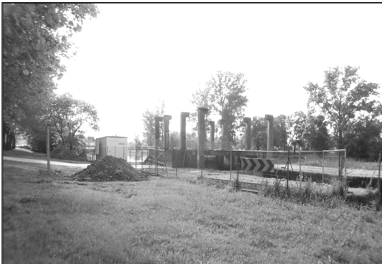
Reconstruction du clapet de régulation de la Charente
