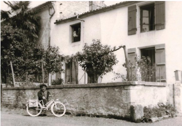
Raoul, son vélo, sa maison à Chaud-Bois
